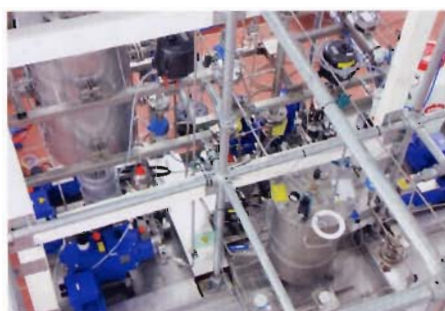
Abb. 4: Im ersten Projektschritt wird die Kohlendioxid-Abtrennung per Absorption untersucht und optimiert. Bran+Luebbe-Pumpen fördern und dosieren dazu korrosives Monoethanolamin (Absorptionsmittel).
